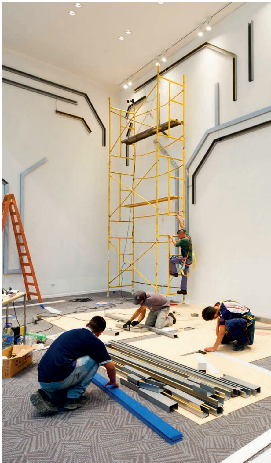
► Lugar a Dudas en plena construcción.
